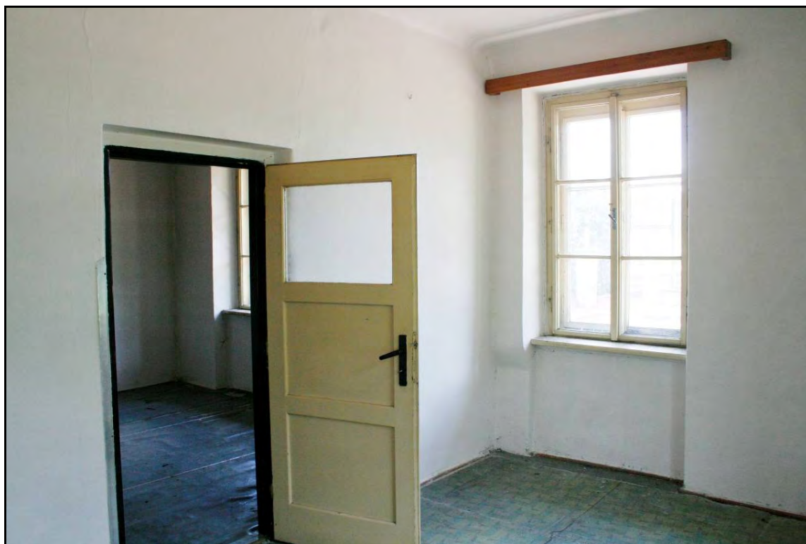
Foto 53 Prostor 224. Pohled směrem k západu. Opět novodobé dveře v železných zárubních. Vnitřní dvoukřídlá okna však pocházejí z doby výstavby výpravní budovy. Foto 6/2011.
