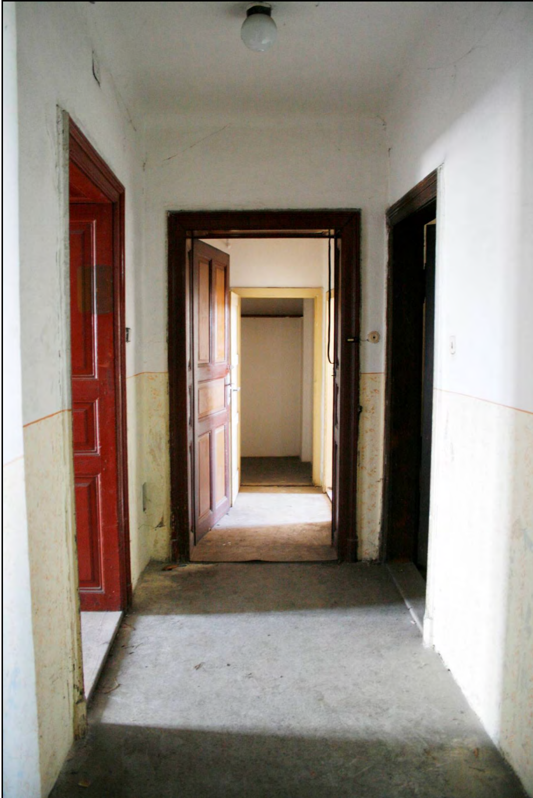
Foto 57 Prostor 301. Pohled směrem ke schodišti. Ve vstupech se nacházejí původní dveře rámové konstrukce, osazené do novodobých zárubní. Foto 6/2011.
