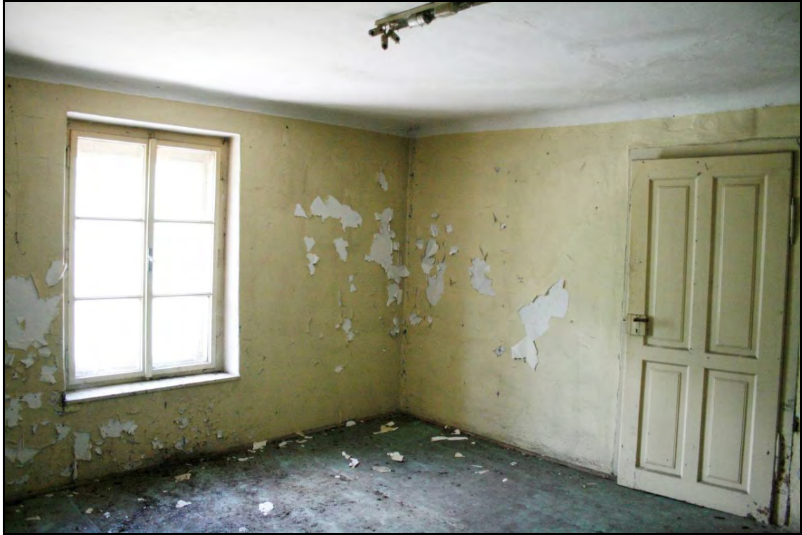
Foto 63 Prostor 403. Pohled na severovýchodní roh jedné z obytných místností vložených do krovu. Foto 6/2011.
