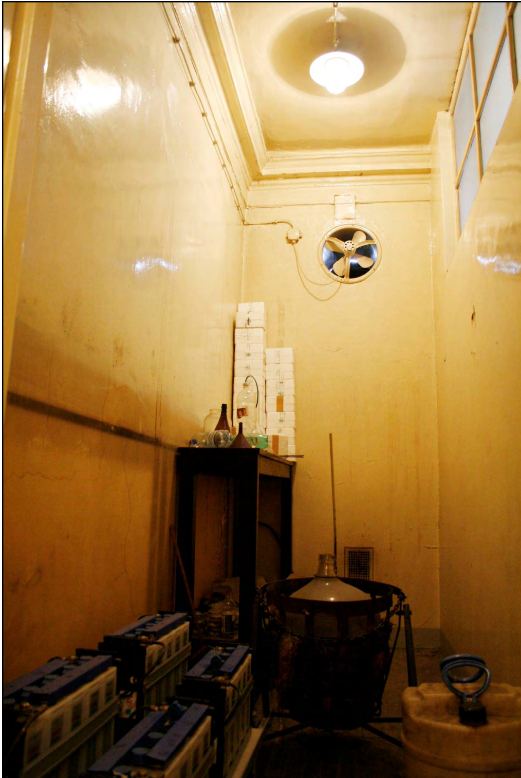
Foto 36 Prostor 109. Pohled do úzkého prostoru vzniklého předělením vstupní haly 101. Pod stropem je vidět průběžná římsa.
