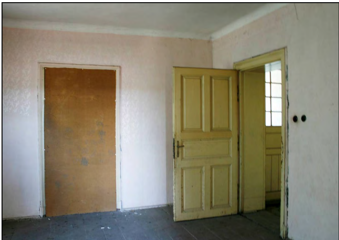
Foto 59. Prostor 306. Pohled na východní stěnu obytné místnosti se zaslepeným vstupem do místnosti 304. Foto 6/2011.
