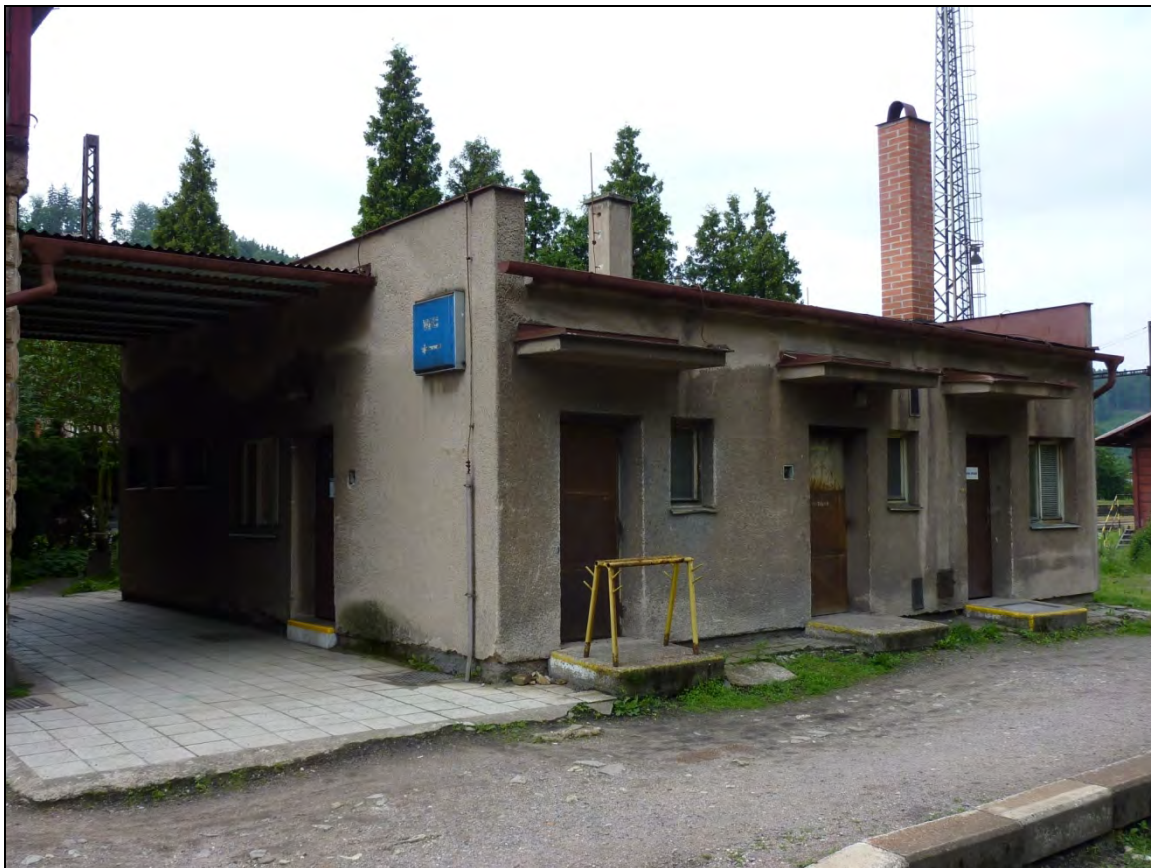
Foto 78 Přízemní přístavek na parcele č. 785 pro vlakové čety a WC. Pohled od severovýchodu. Přístavek doporučujeme při případné rekonstrukci výpravní budovy odstranit bez náhrady.
