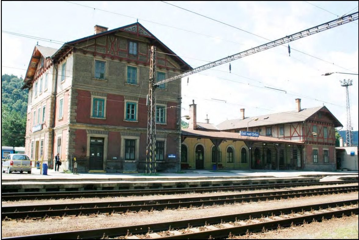
Foto 3 Celkový pohled na výpravní budovu nádraží od severovýchodu (letohradské nástupiště). Foto 6/2011.
