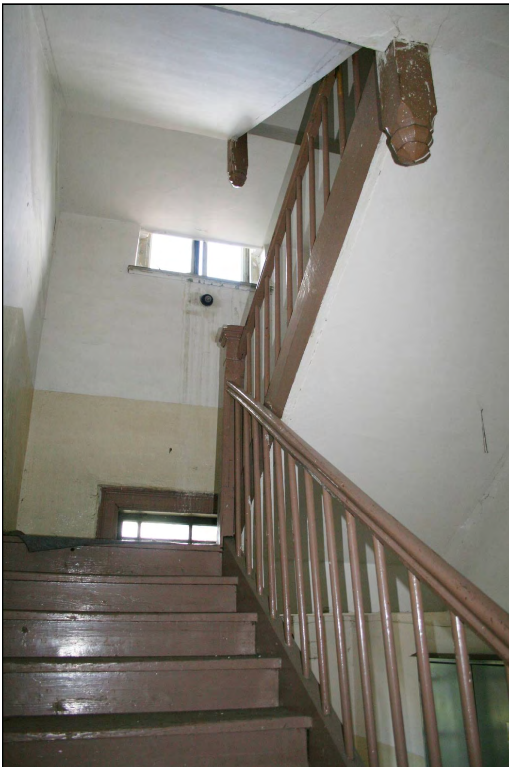
Foto 51 Prostor 219 . Pohled na dřevěné schodiště do 2. patra. Foto 6/2011.
