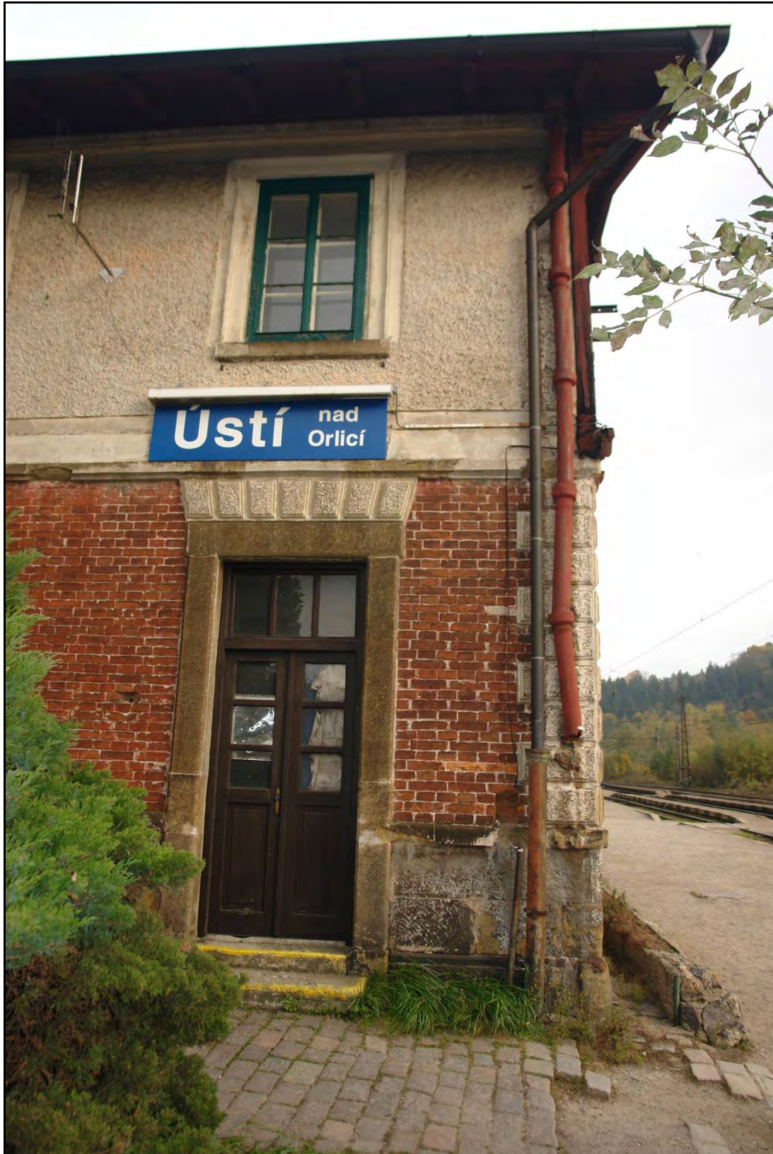
Foto 18 Detail poslední jižní osy západního průčelí západního křídla. Vidíme, že fasáda je řešena shodně jako u východního křídla. Režné zdivo je na této straně bez doplňujících červených nátěrů. Foto 6/2011.
