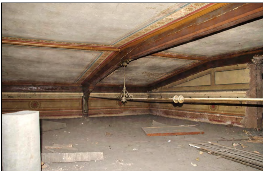
Foto 81 Pohled severovýchodním směrem do koutu svíraného severní obvodovou zdí středního křídla (na snímku vlevo) a stěnou oddělující průchod 102 a 115 (na snímku vpravo). Při pravé straně je vidět horní nadsvětličková část vstupu z průchodu do původní čekárny III. a IV. třídy, která byla podobně jako sousední čekárna pro cestující I. a II. třídy otevřena do krovu, bohatě zdobeného omítaným a amlovaným podhledem. Foto 29. 7. 2011, z doby doměřování objektu.
