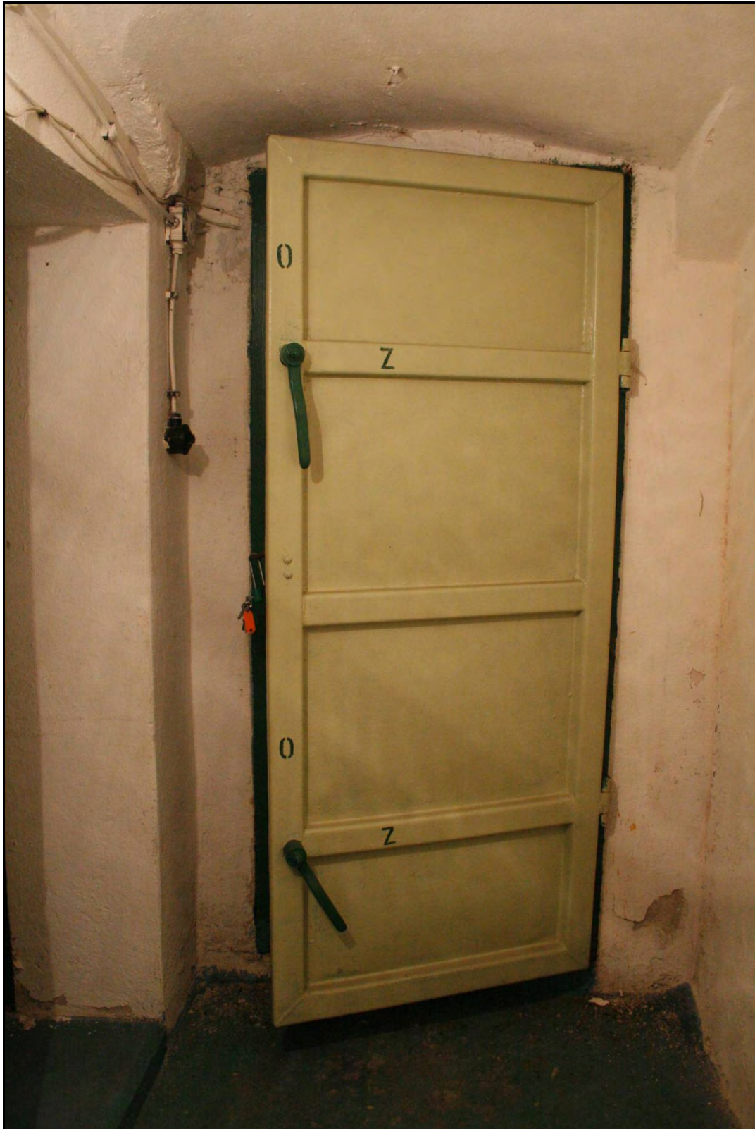
Foto 29 Prostor 005. Detail bezpečnostních jednokřídlých železných dveří do prostoru krytu civilní obrany. Foto 6/2011.
