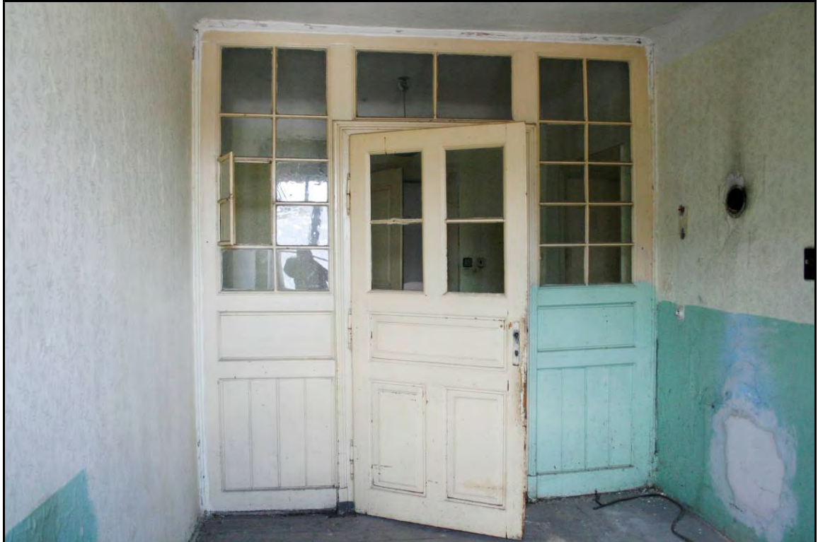
Foto 58 Prostor 303. Pohled na dělicí dřevěnou prosklenou stěnu bývalé kuchyně. Foto 6/2011.
