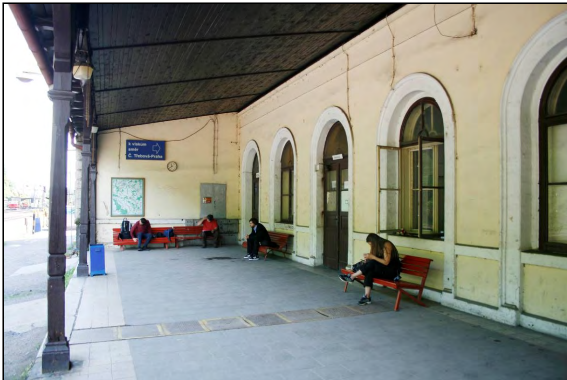
Foto 26 Pohled na kryté severní nástupiště směrem k východu. Na severním nástupišti chybí původní zábradlí. Dlažba rovněž novodobá, byť odlišná od jižního perónu. Foto 6/2011.
