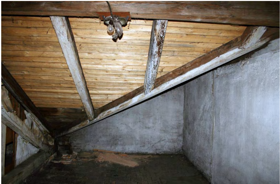
Foto 64 Prostor 405. Pohled do volné části krovu na východním křídlem, využívané dříve ke skladování. Foto 6/2011.
