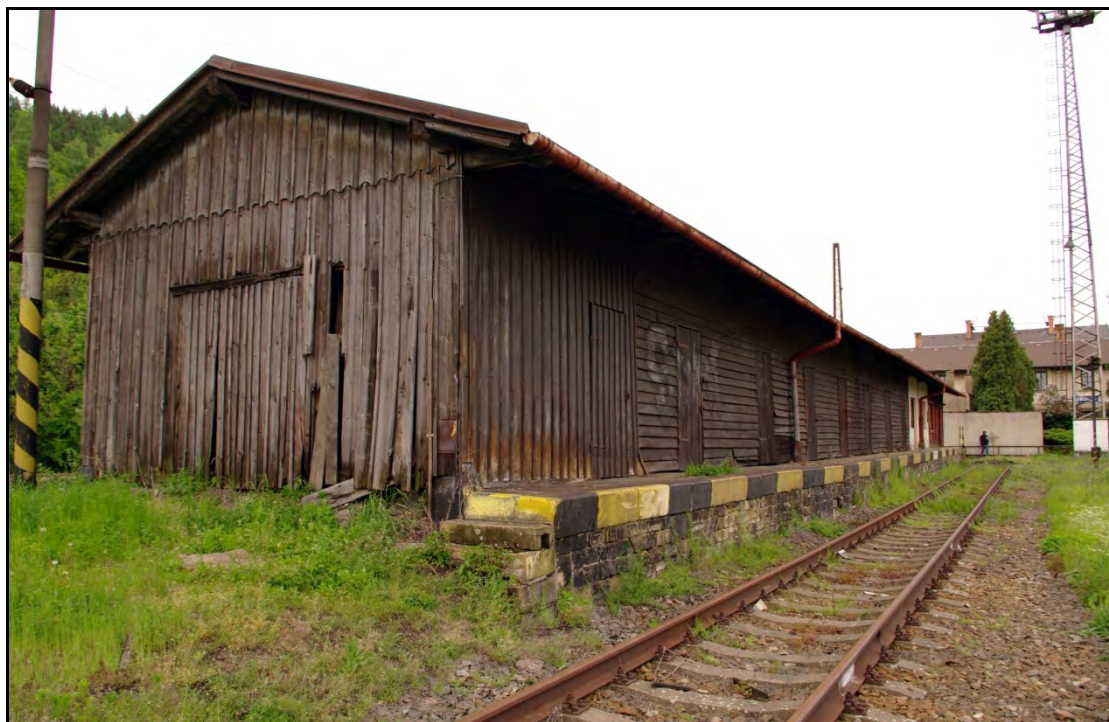
Foto 73 Dřevěné skladiště s nákladovou rampou na parcele č. 791. Pohled od jihozápadu. Pohled na západní část skladiště s bedněnými stěnami.
