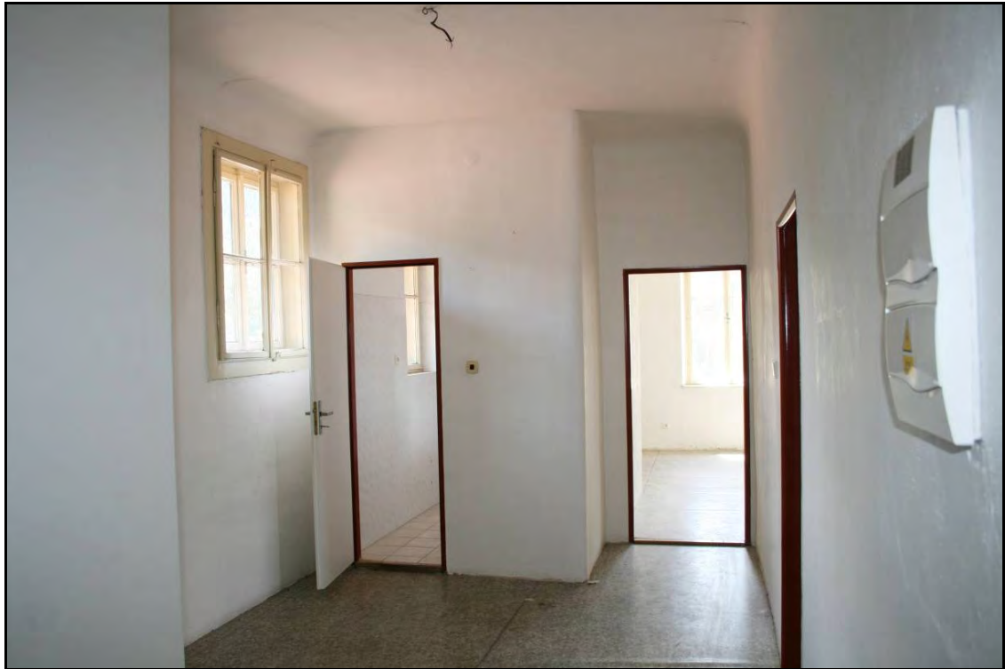
Foto 54 Prostor 226. Pohled na nově upravenou místnost s vestavěnou koupelnou po levé straně při východní zdi křídla. Foto 6/2011.
