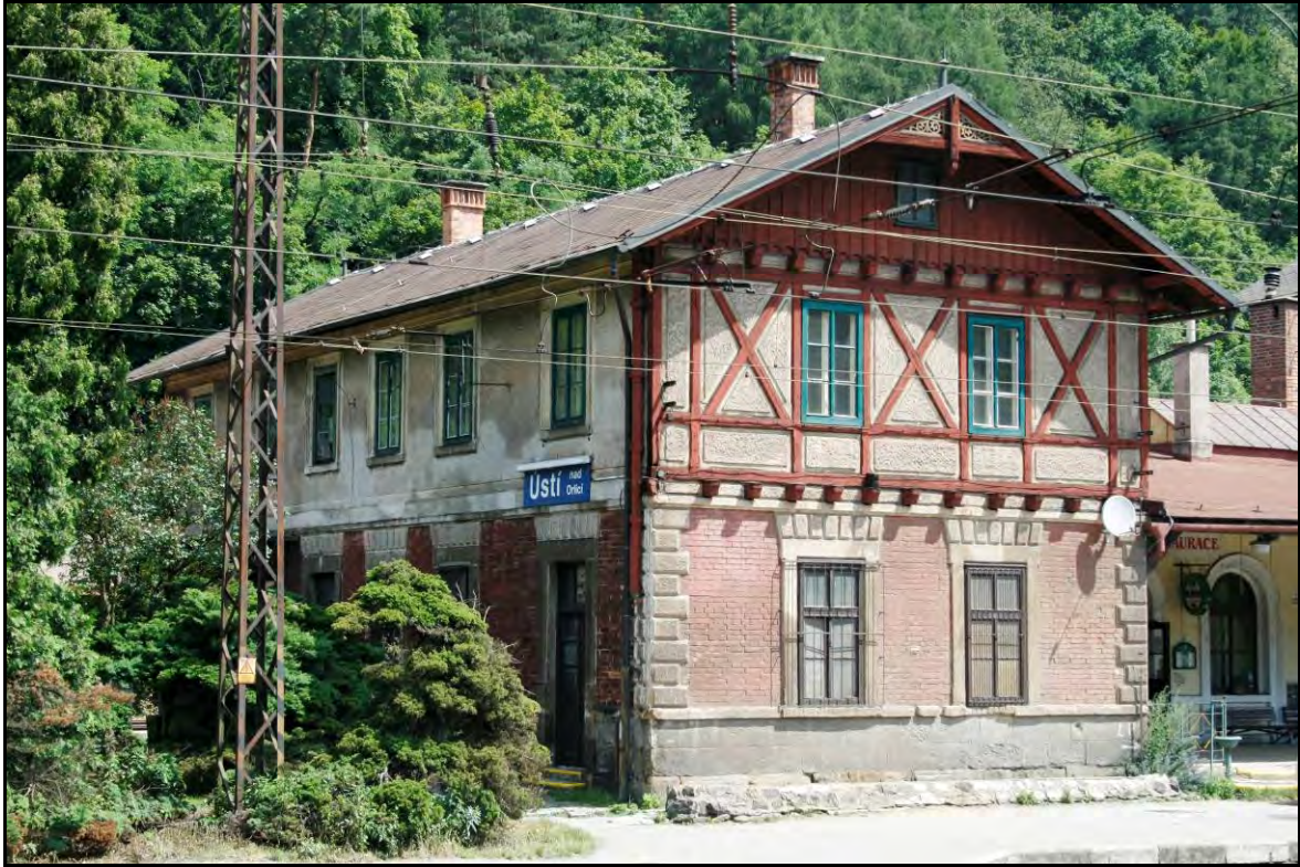
Foto 13 Celkový pohled od jihozápadu na západní křídlo výpravní budovy. Foto 6/2011.
