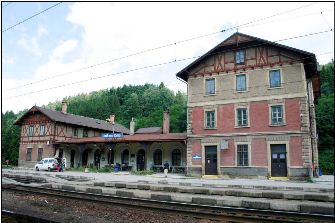
Foto 4 Celkový pohled na výpravní budovu nádraží od jihovýchodu (pražské nástupiště). Foto 6/2011.
