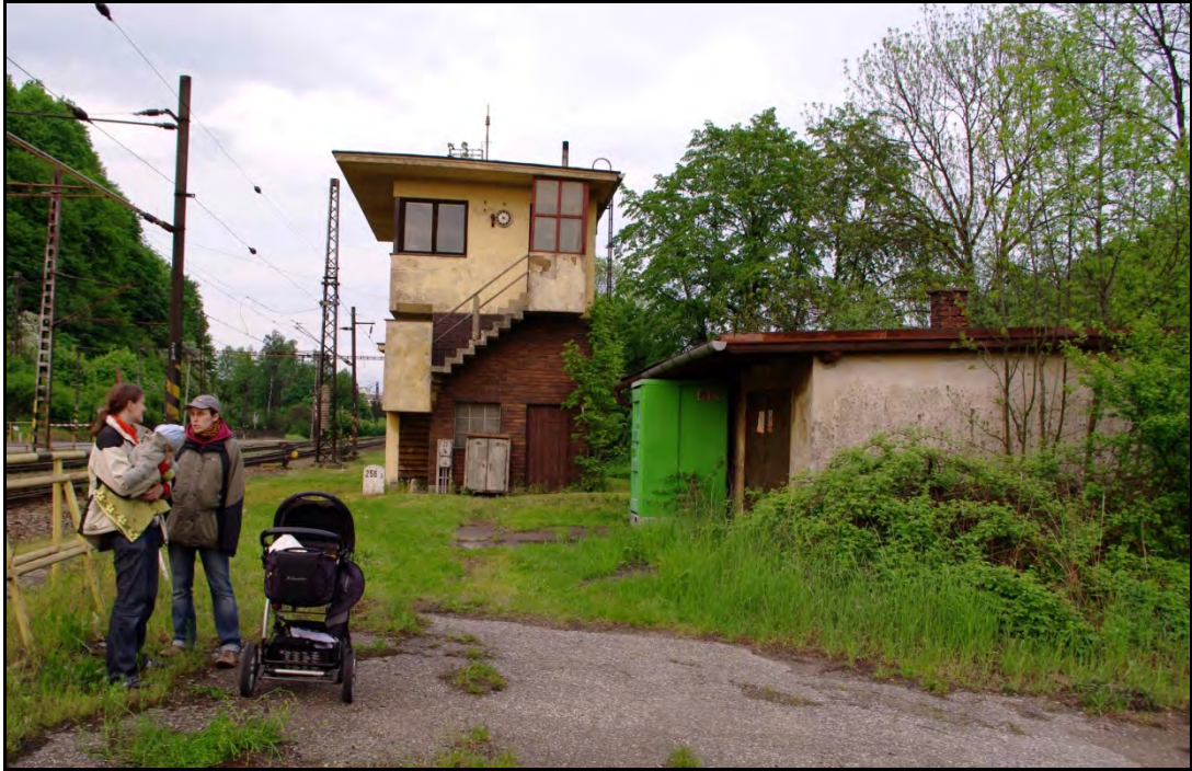
Foto 74 Hradlo na parcele č. 1282 ve východní části nádraží, postavené patrně na počátku 30. let 20. století. Stavba nese prvky purismu a raného funkcionalismu.
