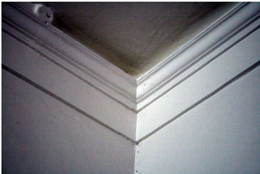
Foto 42 Prostor 121. Detail profilované štukové římsy, nepochybně původní, z doby výstavby objektu. Foto 6/2011.
