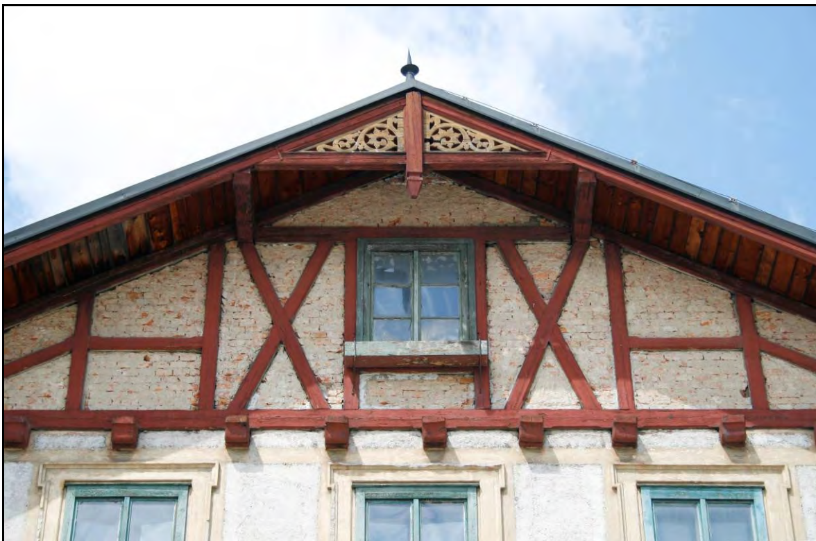
Foto 12 Detailní pohled na hrázděnou konstrukci podkroví východního průčelí východního křídla. Na celé ploše chybí hrubá omítka, shodná se severním průčelím. Foto 6/2011.
