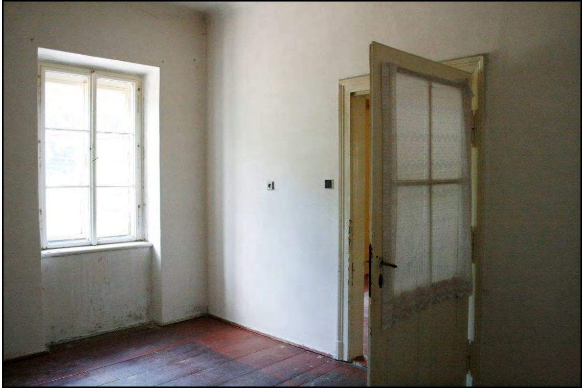
Foto 49 Prostor 206. Pohled na severovýchodní roh s oknem a vstupem z místnosti 205. Foto 6/2011.
