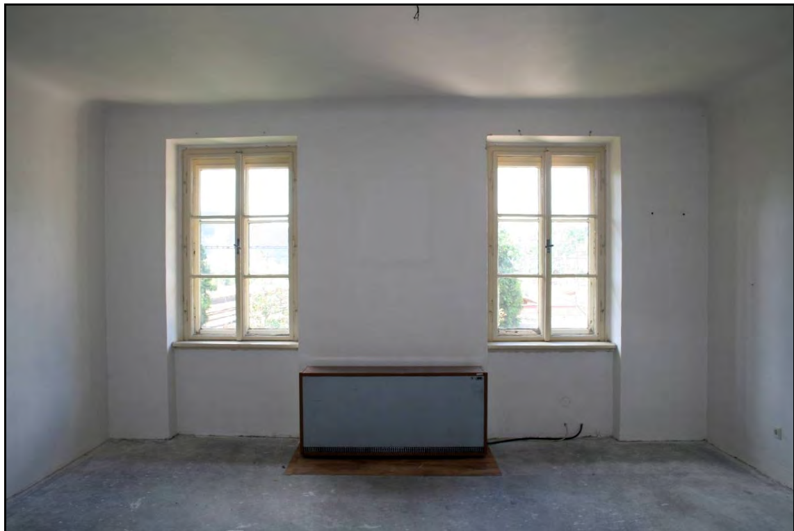
Foto 55 Prostor 229. Pohled na západní stěnu s dvojicí oken a akumulčními kamny. Vnitřní okna jsou původní. Foto 6/2011.
