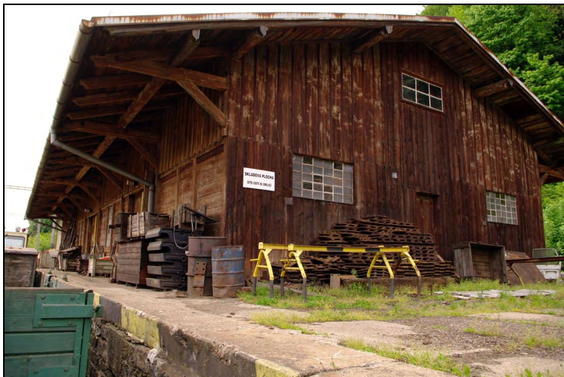
Foto 71 Dřevěné skladiště s nákladovou rampou na parcele č. 787. Pohled od jihovýchodu. Skladiště je v dobrém stavebně technickém stavu.
