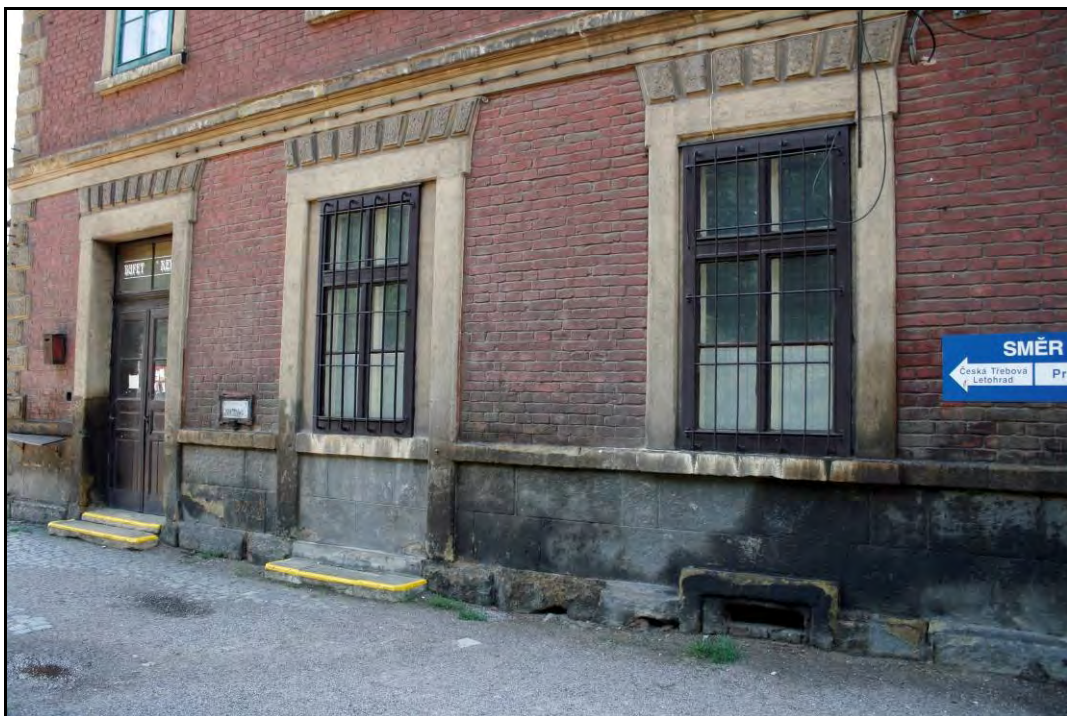
Foto 10 Pohled na přízemí severního průčelí východního křídla. Na fotografii je vidět celkové řešení plochy fasády z režného zdiva, kamenným soklem, šambrán oken a ostění vstupu. Nad okny i vstupy jsou nástavce s bosovaných kvádrů, stejně jako na nárožích. Jediný vstup dnes vede do zrušeného bufetu Jarka. Foto 6/2011.
