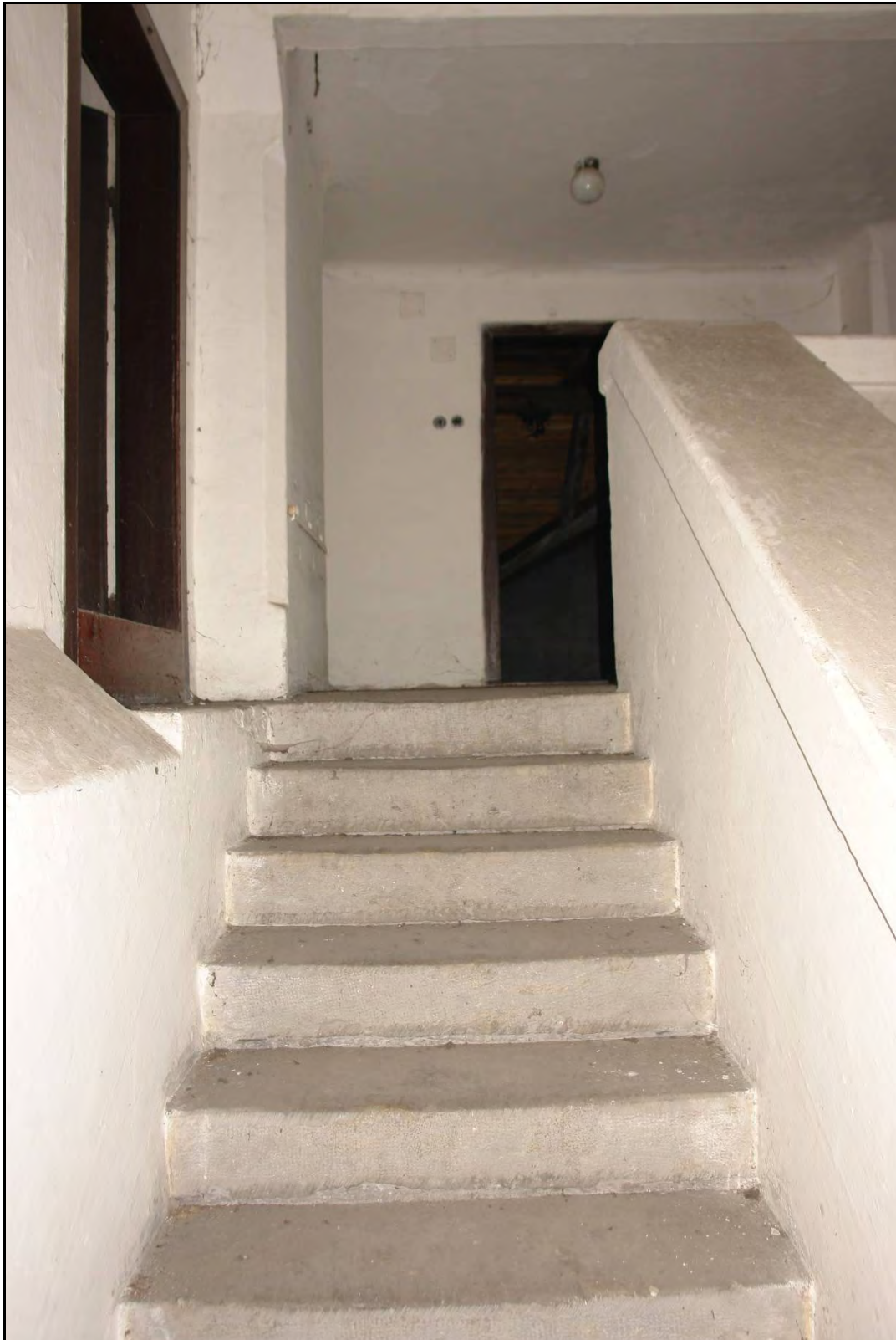
Foto 61 Závěr schodiště před vstupem do podkroví východního křídla. Stupně jsou kamenné.
