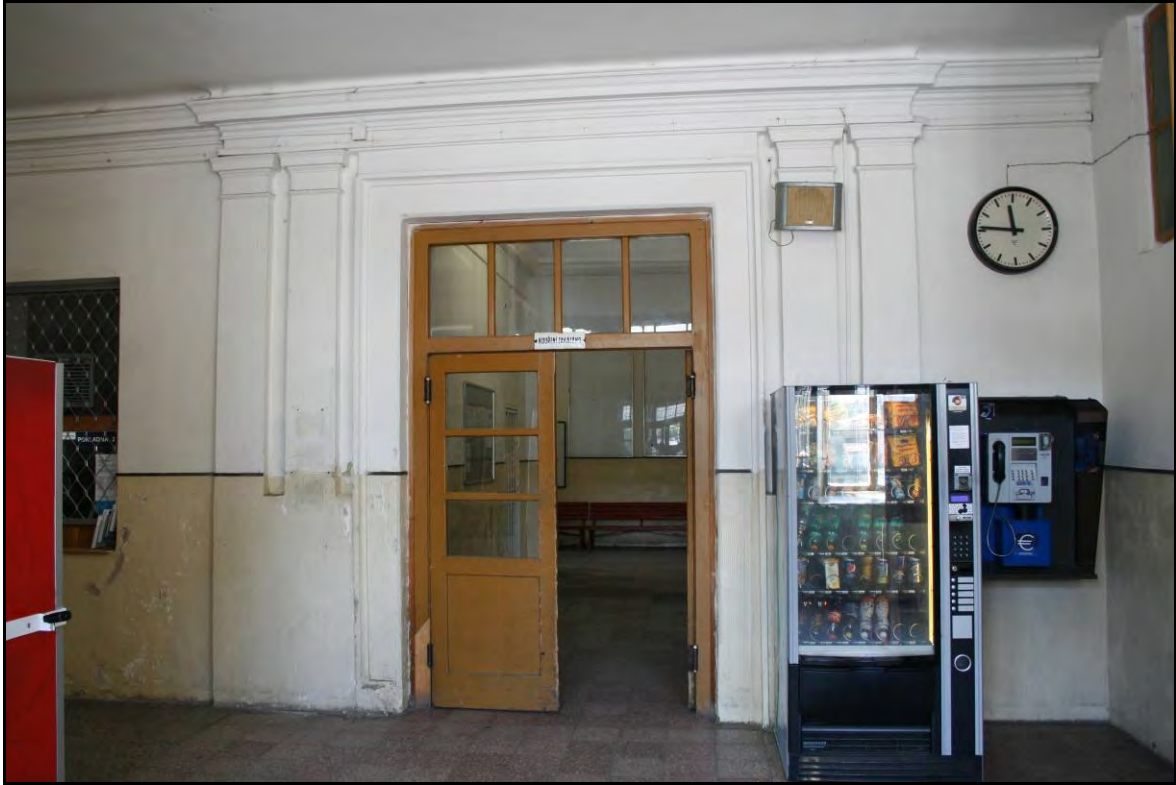
Foto 32 Prostor 101. Pohled na západní stěnu bývalé vstupní haly se vstupem do prostoru 002. Na fotografii vidíme původní rámování vstupu pilastry, vynášejícími římsu, která obíhá celý obvod místnosti. Foto 6/2011.
