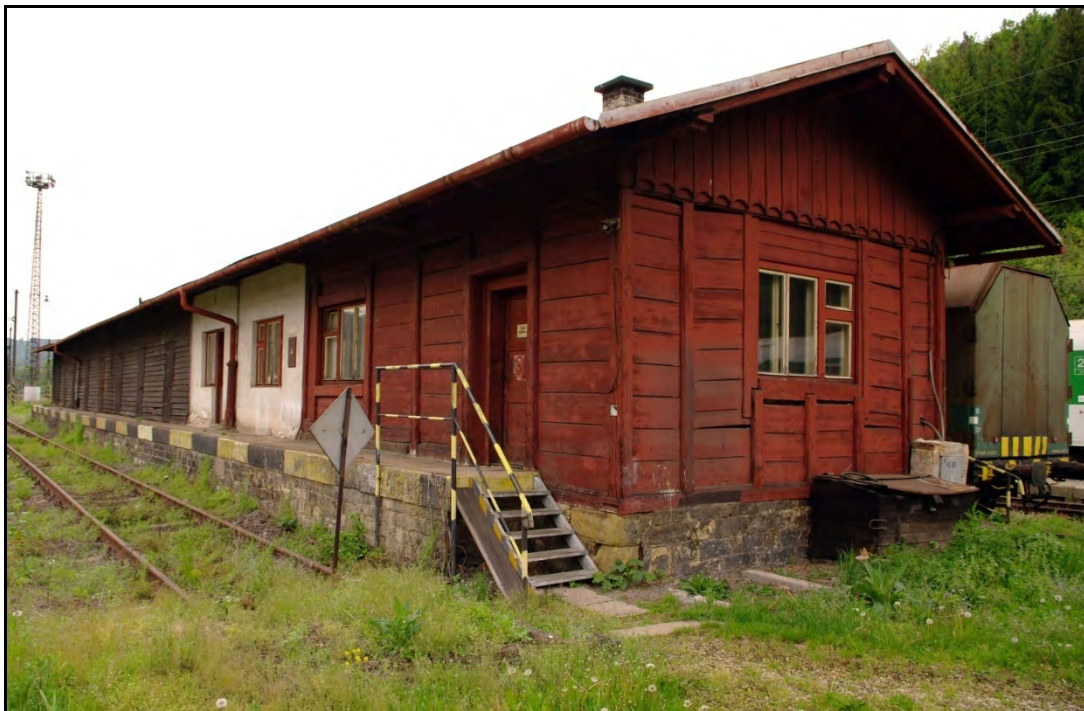
Foto 72 Dřevěné skladiště s nákladovou rampou na parcele č. 791. Pohled od jihovýchodu. Budova se nachází v ose za západním křídlem výpravní budovy na ostrůvku mezi pražskou a letohradskou tratí. Na snímku západní část je dřevěné konstrukce, následuje zděný střed a dlouhá západní část se skladištěm s bedněnými stěnami.
