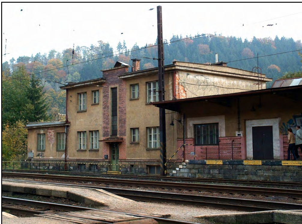
Foto 75 Kancelářská budova na parcele č. 366 se nachází po jižní straně pražské trati. Byla postavena na počátku 30. let a je jedním z několika dokladů nedokončené funkcionalistické přestavby nádraží (vedle hradla). Na jednopatrovou kancelářskou budovu navazuje dlouhé přízemní zděné skladiště ze stejné doby.
