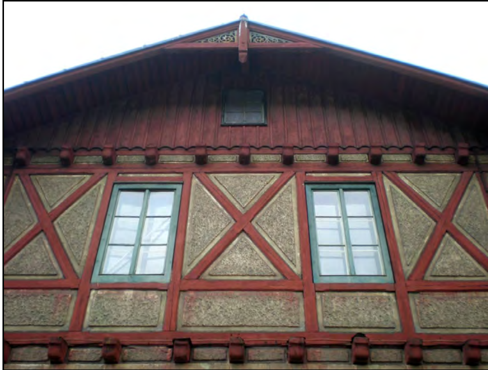
Foto 19 Detail 1. patra a podkroví jižní fasády západního křídla. Na fotografii je vidět bedněný štít se zhlavími trámů tvořících patrové římsy. Pozednice hrázděné konstrukce je osazena na zhlaví stropních trámů spodního podlaží. Zhlaví jsou dekorativně profilována. Foto 6/2011.
