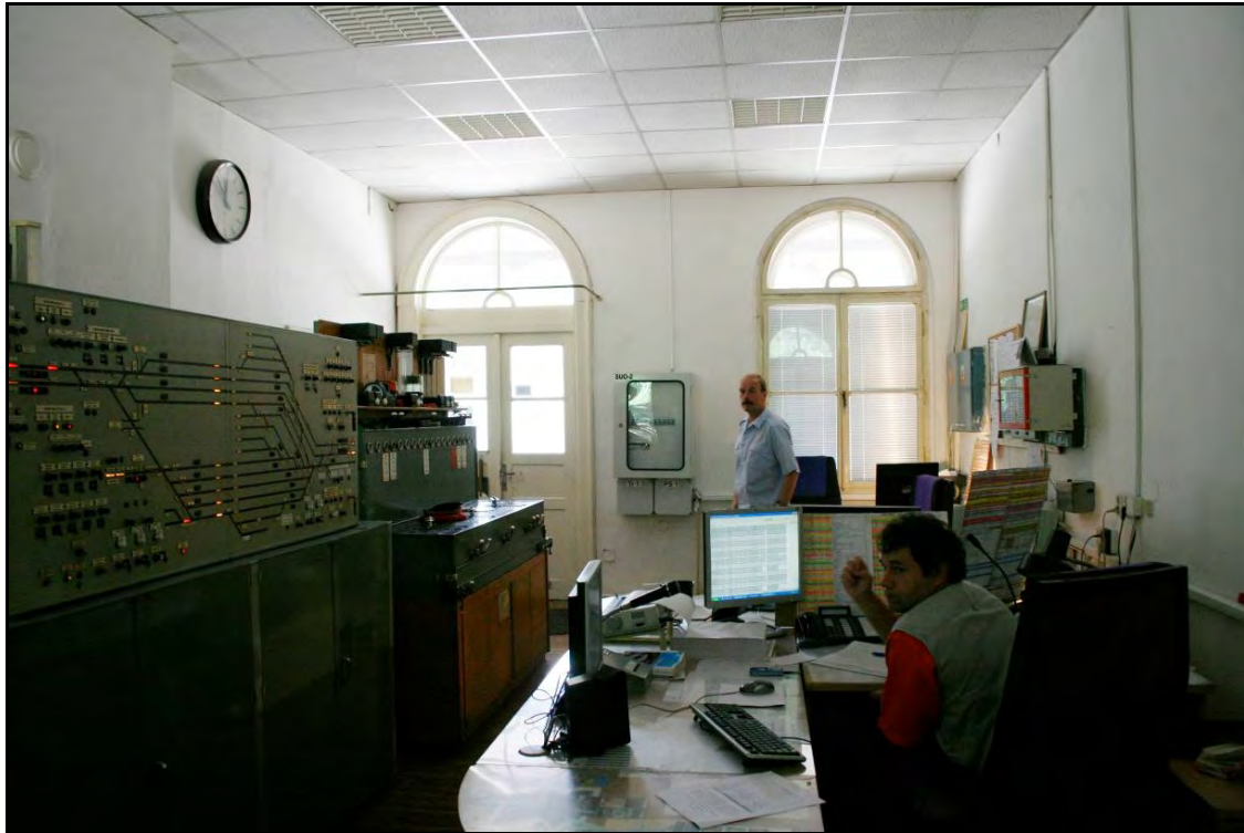
Foto 39 Prostor 117. Pohled na jižní stěnu se vstupem z pražského nástupiště. Místnost má novodobý pohled, nad nímž se nachází původní průhled do krovu z doby výstavby výpravní budovy. Prostor dnes slouží jako dopravní kancelář.
