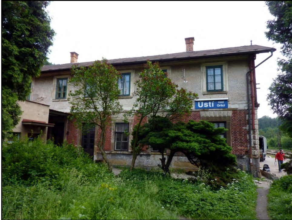
Foto 76 Parková úprava v ploše před západní fasádou západního jednopatrového křídla výpravní budovy. Dnes je toto zákoutí neupravené, po severní straně ukončené přízemním přístavkem, jenž slouží jako zázemí pro vlakové čety a veřejné WC. Původně se v celém rozsahu plochy nacházela zahrádka, později lednice a prádelna.
