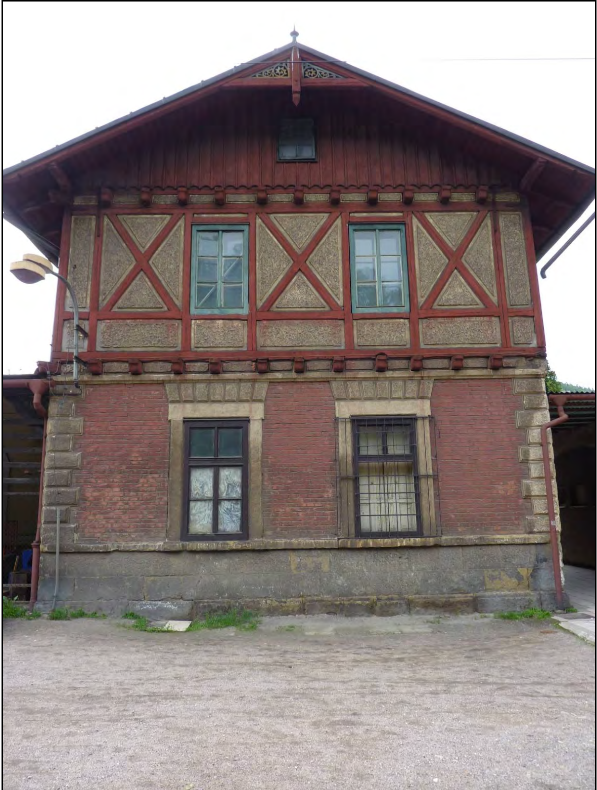
Foto 14 Severní průčelí západního křídla, jedno z nejzachovalejších u výpravní budovy. Foto 6/2011.
