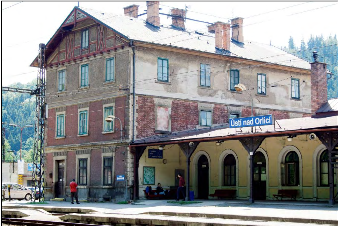
Foto 5 Pohled na východní křídlo výpravní budovy od severozápadu. Foto 6/2011.
