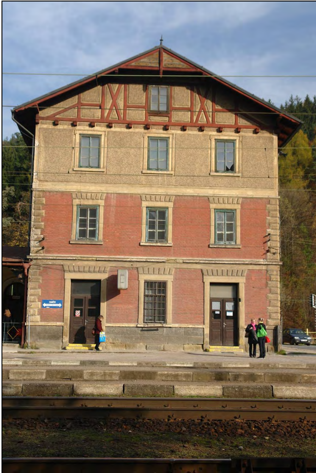
Foto 7 Pohled na jižní průčelí východního křídla s původními vstupy. Foto 6/2011.
