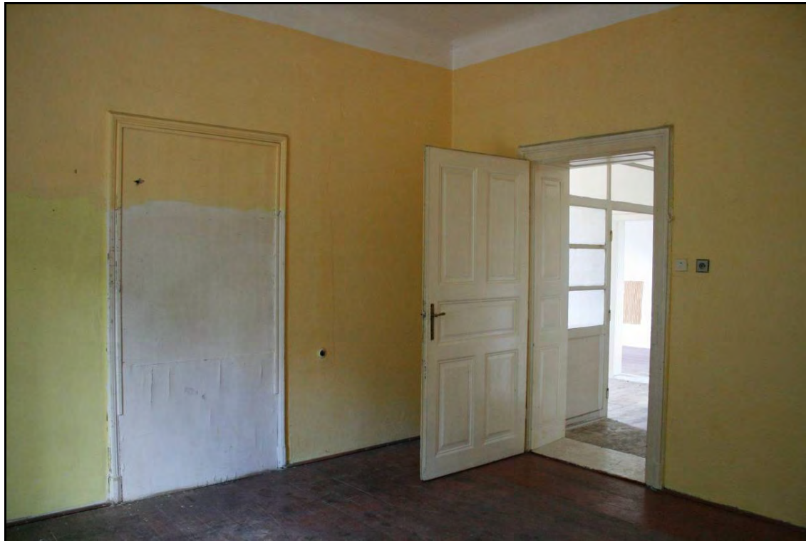
Foto 48 Prostor 205. Pohled na východní, původní vstup ze sousední místnosti, dnes zaslepený. Foto 6/2011.
