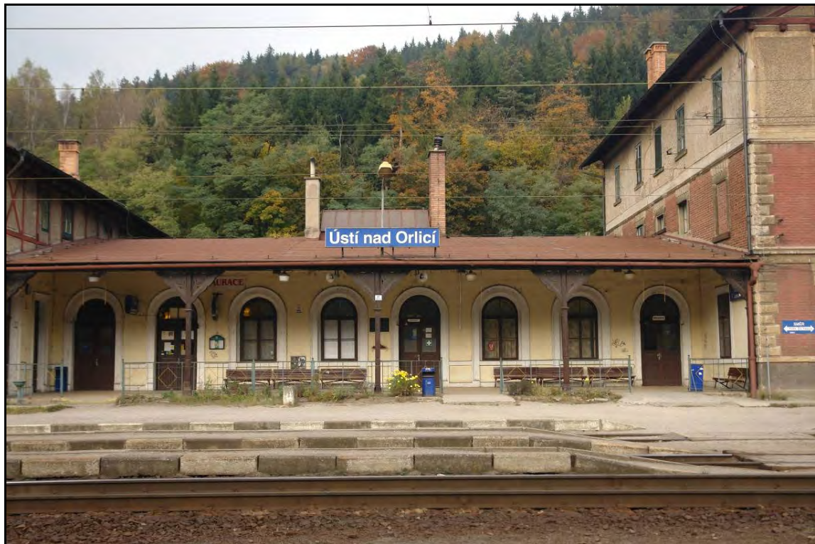
Foto 20 Celkový pohled na jižní (pražské) nástupiště. Symetricky je řešeno i protilehlé severní nástupiště (letohradské). Foto 6/2011.
