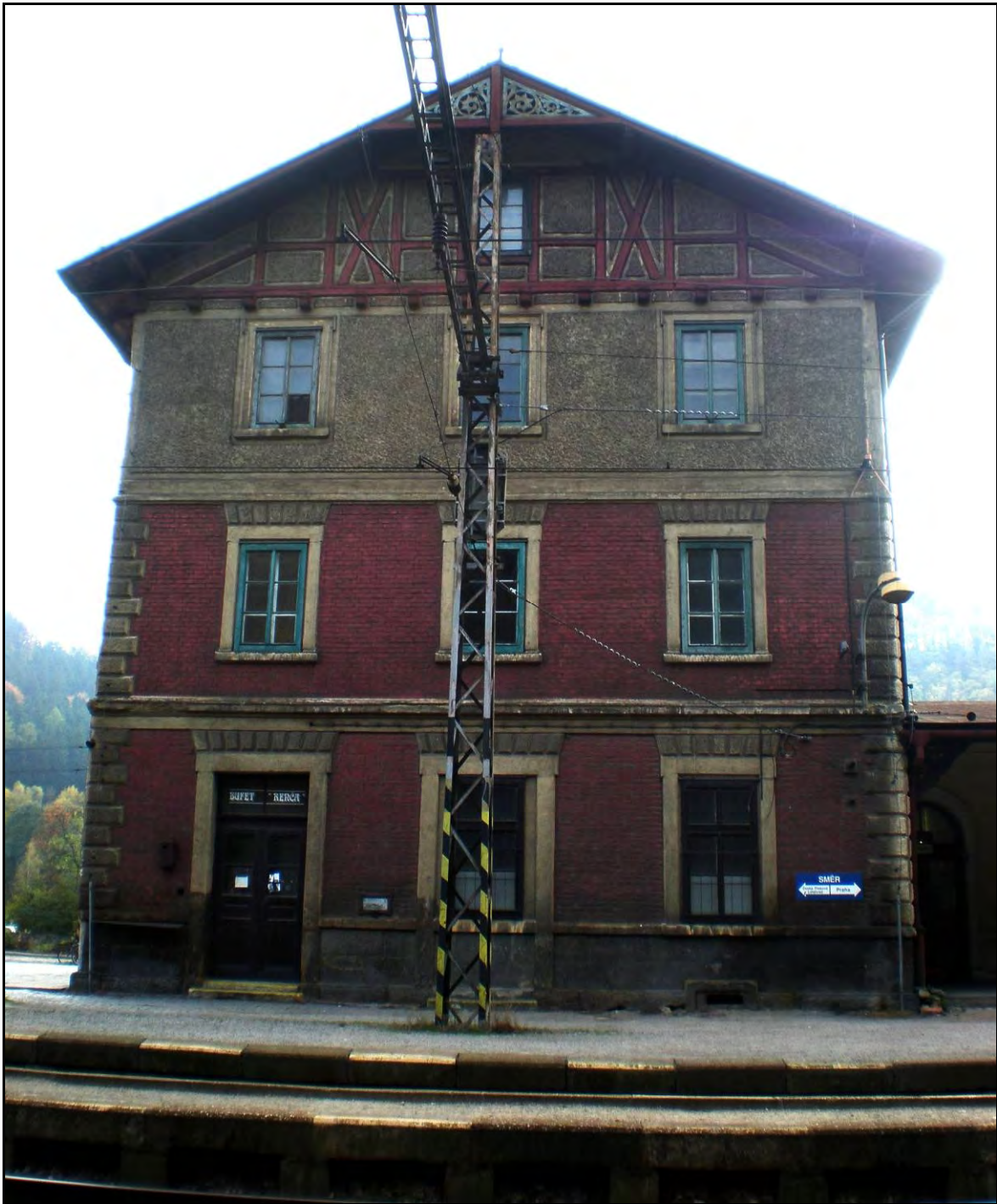
Foto 8 Pohled na severní průčelí východního křídla. Ve střední ose přízemí je patrný druhotně zrušený vstup, předělaný na okno. Foto 6/2011.
