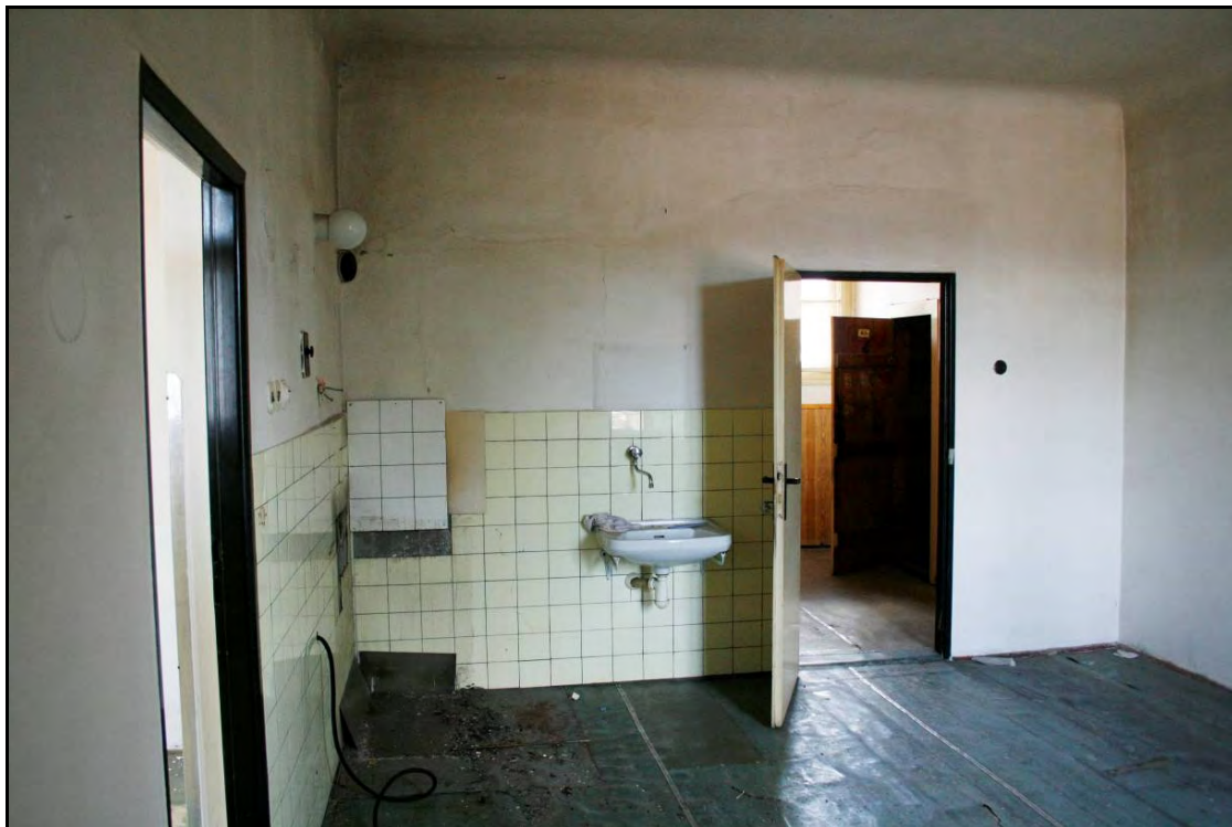
Foto 52 Prostor 223. Pohled směrem k východu na zbytek po kuchyňském koutu. Na fotografii jsou patrné nové dveře v železných zárubních. Foto 6/2011.
