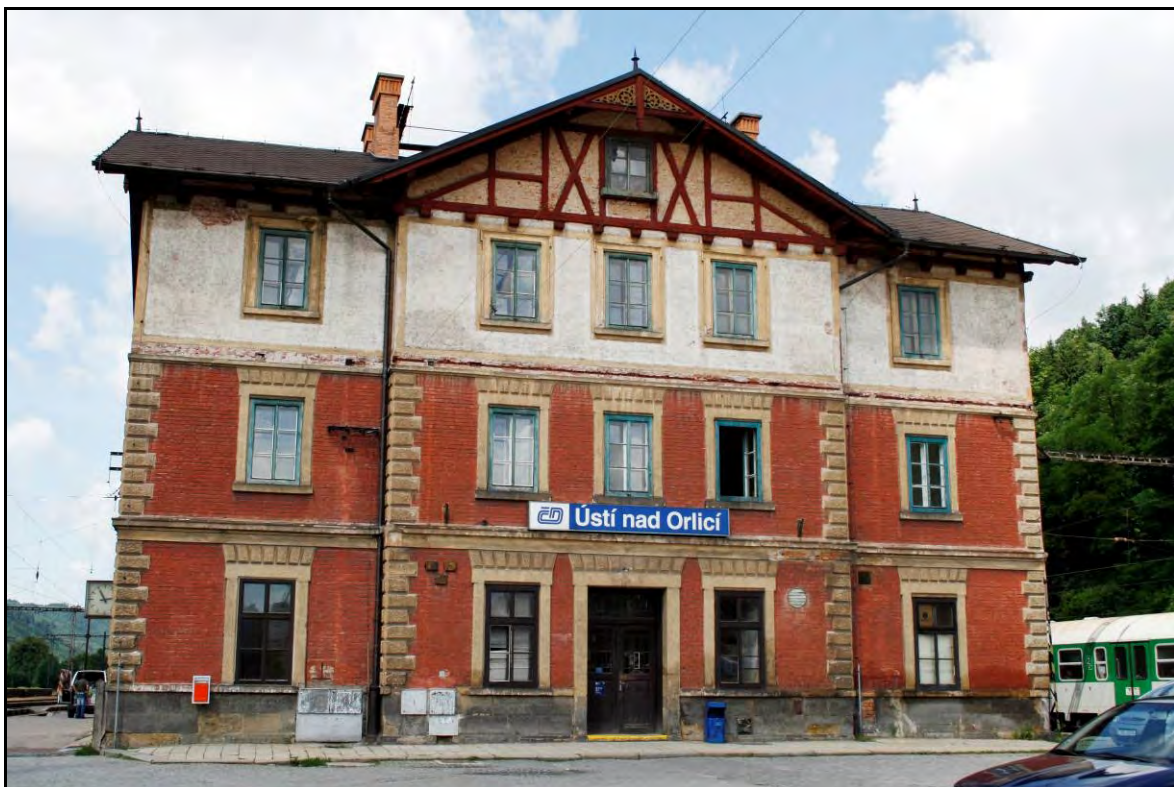
Foto 6 Pohled na východní průčelí východního křídla s hlavním vstupem. Foto 6/2011.
