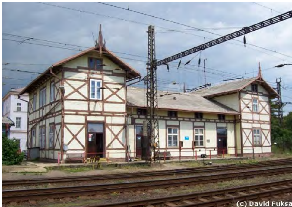
Foto 86 Chomutov – seřadovací nádraží. Typický a poměrně zřídka příklad celohrázděné nádražní budovy, v tomto případě citlivě opravené a udržované.
