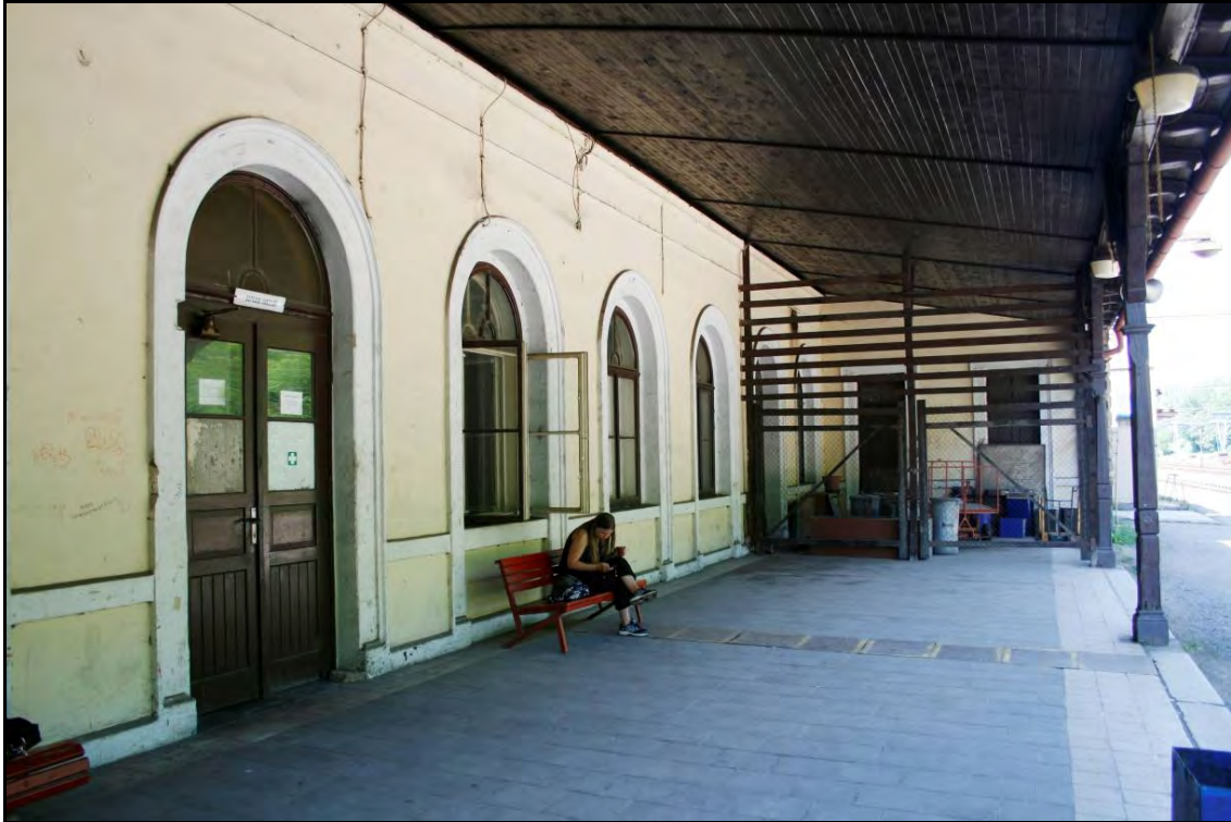
Foto 25 Pohled na kryté severní nástupiště směrem k západu. Na konci jsou patrné vstupy do ke dvěma původním záchodům (pánskému a dámskému). Řešení je shodné s jižním nástupištěm. Foto 6/2011.
