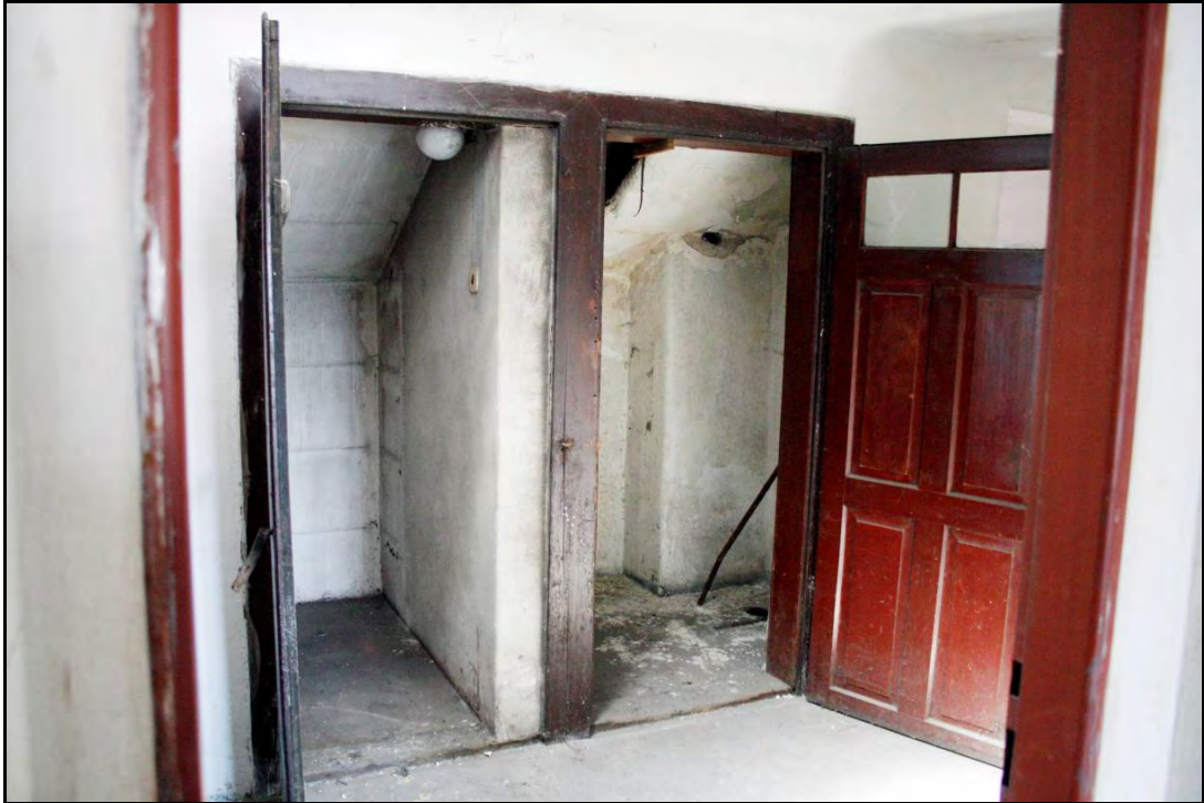
Foto 67 Prostory 413 a 414, sloužící jako záchody. Jsou přístupné z chodby 401. Foto 6/2011.
