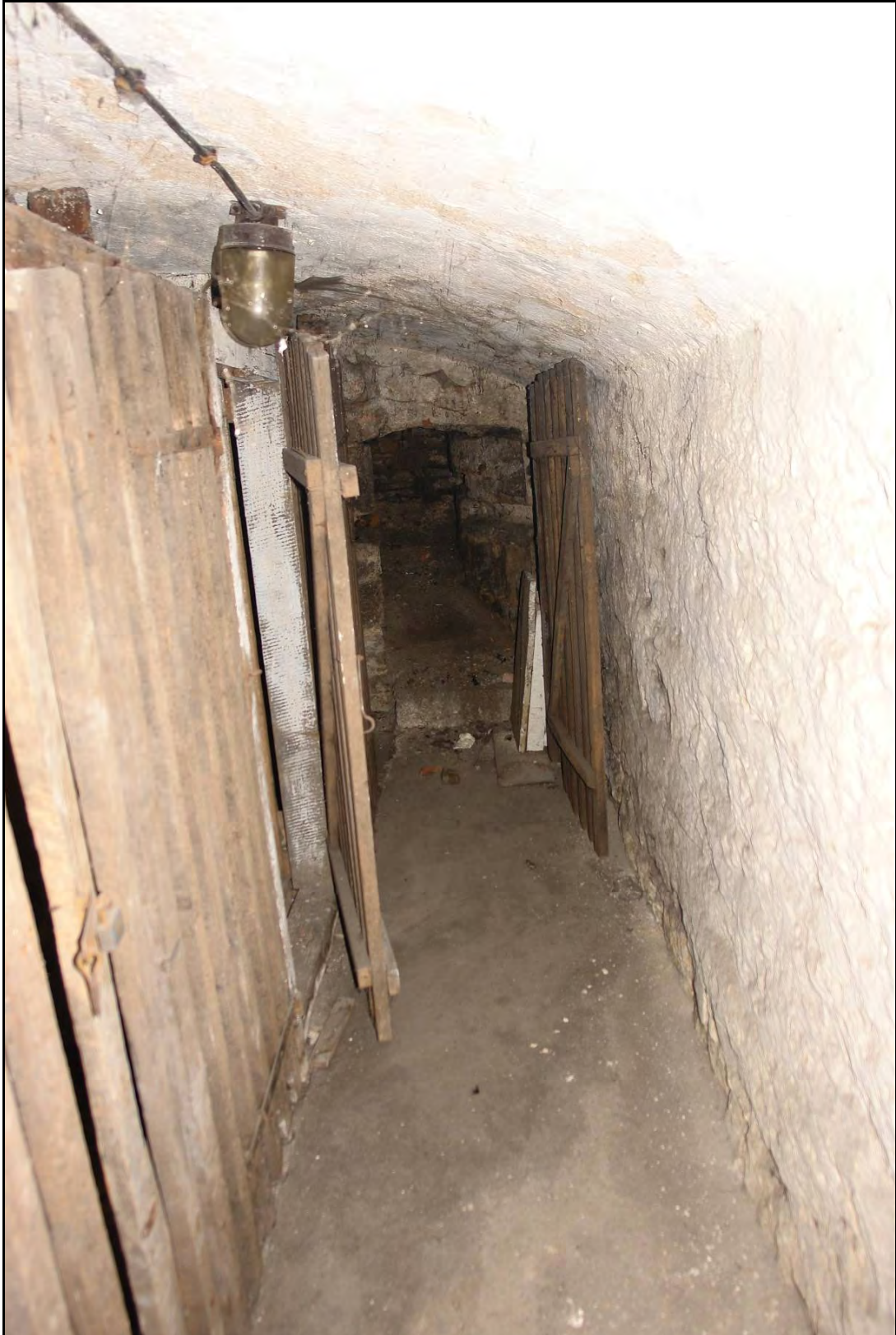
Foto 28 Prostor 002 . Pohled směrem k východu do sklepního prostoru. Po levé straně vestavěná dřevěná kóje. Na konci se nachází ústí odvětrávacího otvoru. Foto 6/2011.
