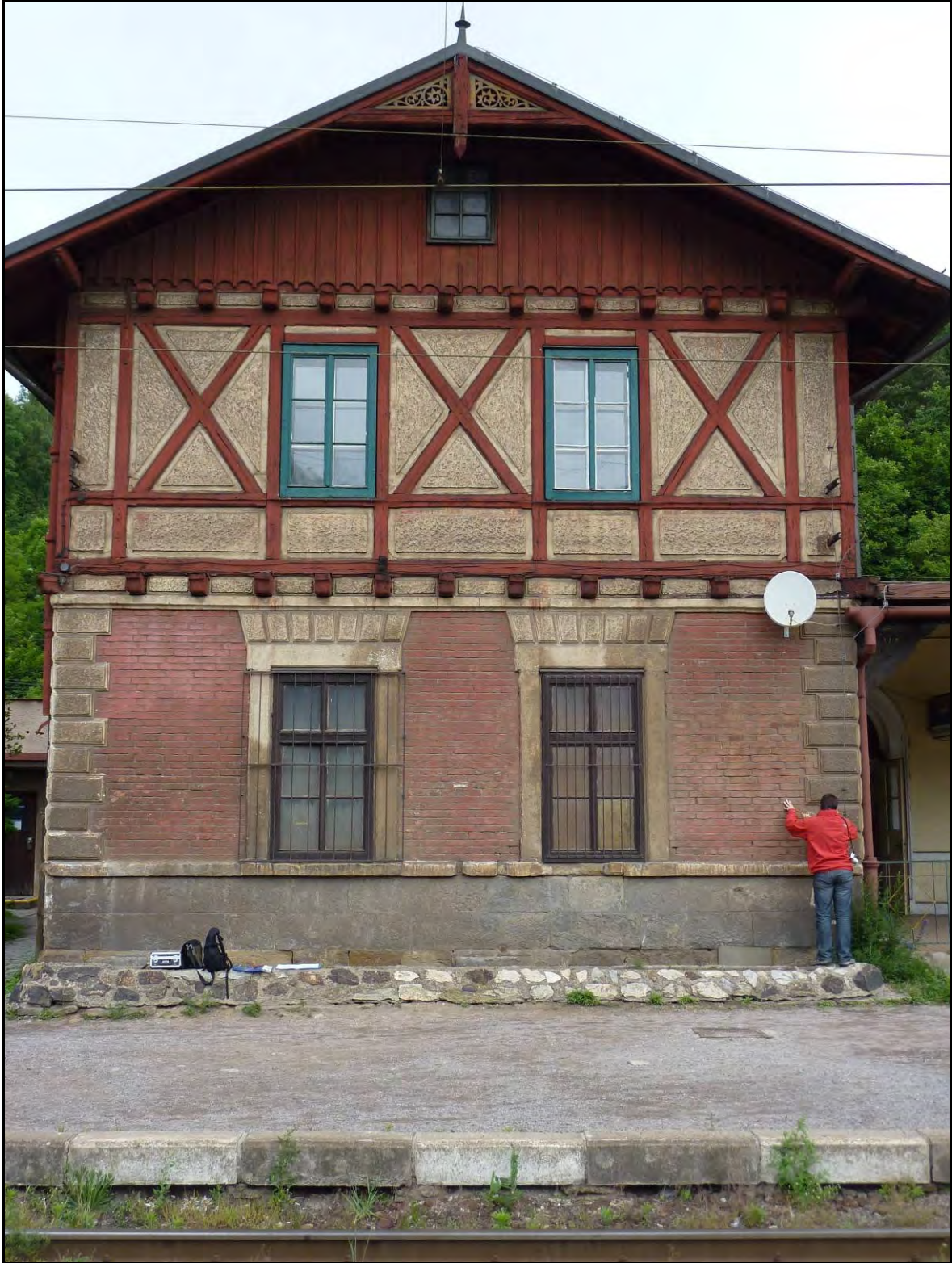
Foto 15 Jižní průčelí západního křídla. Snímek pořízen v době odběru vzorků pro laboratorní rozbor barevnosti, struktury omítky a petrografie. Foto 6/2011.
