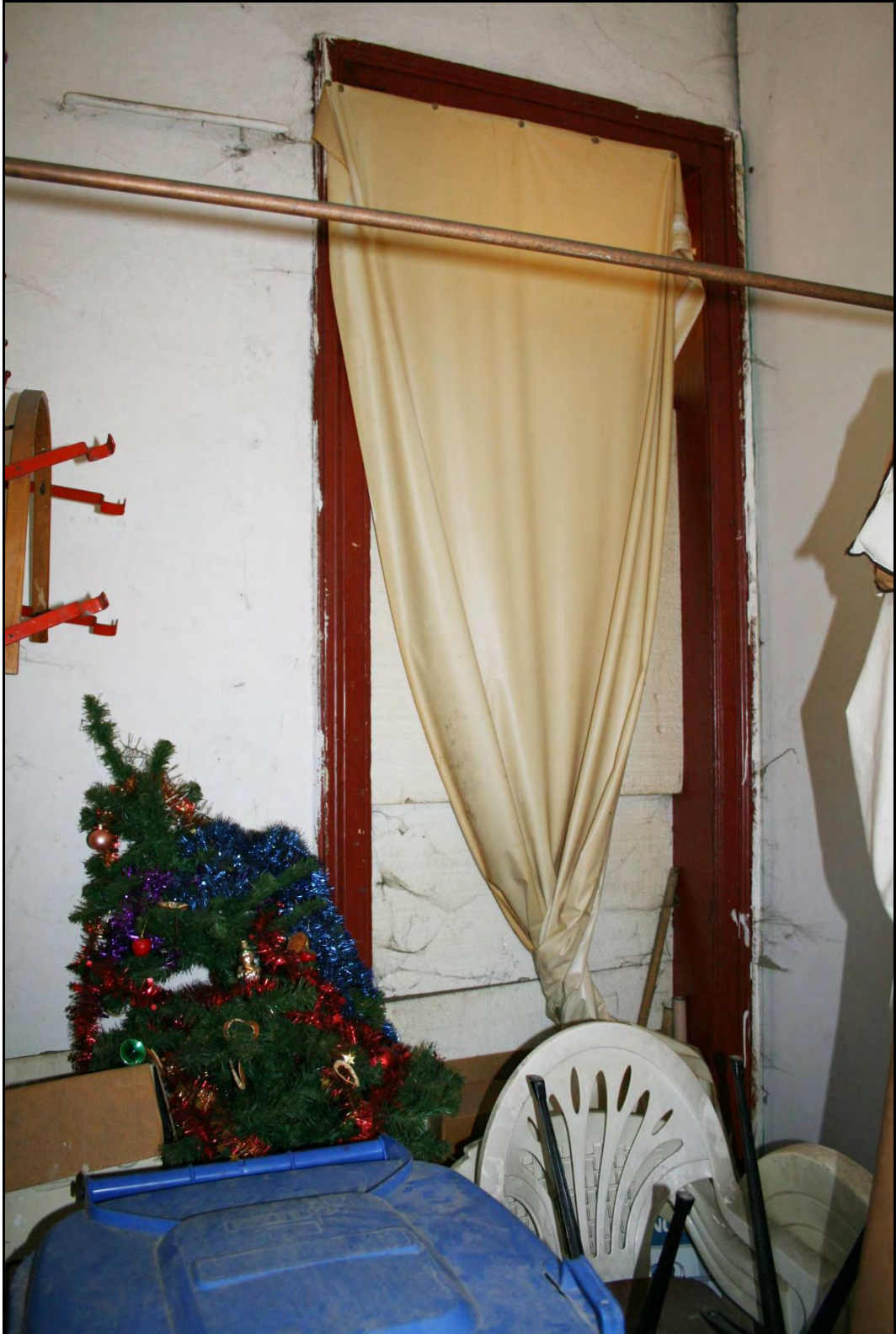
Foto 46 Prostor 130. Pohled na profilované dřevěné zárubně původního vstupu z nástupiště. Vstup je dnes zaslepený. Foto 6/2011.
