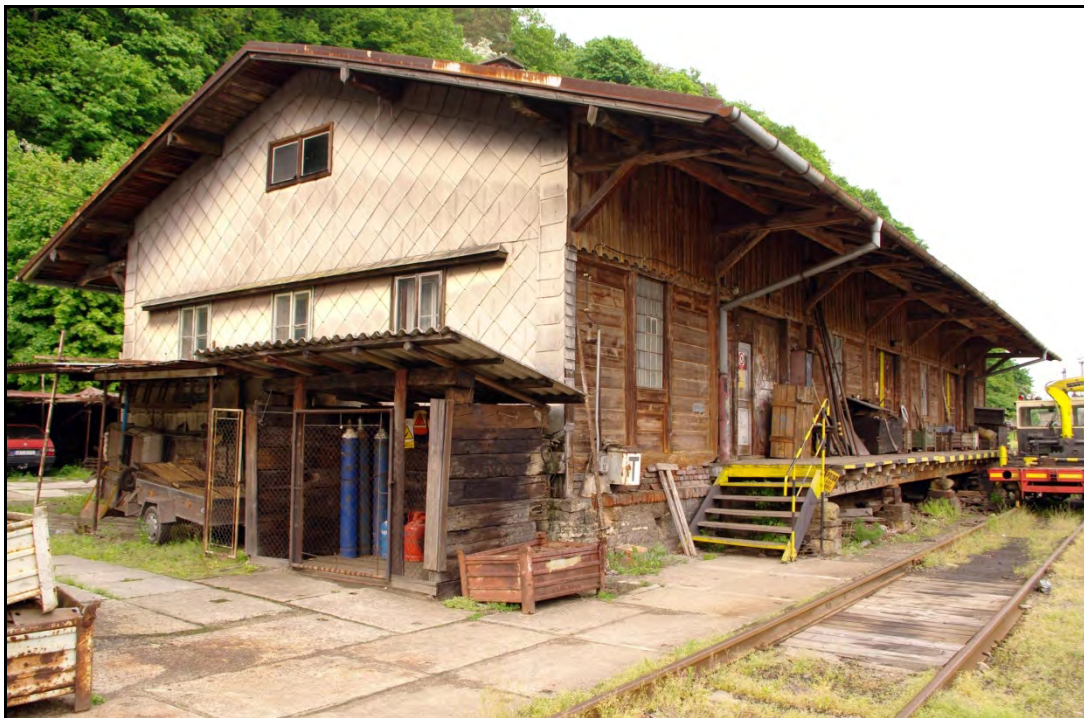
Foto 70 Dřevěné skladiště s nákladovou rampou na parcele č. 787. Pohled od jihozápadu. Jde o budovu postavenou nejpozději v 1. desetiletí 20. století. Čelní západní strana pobita čtvercovými eternitovými šablonami (patrně jde o mladší úpravu).
