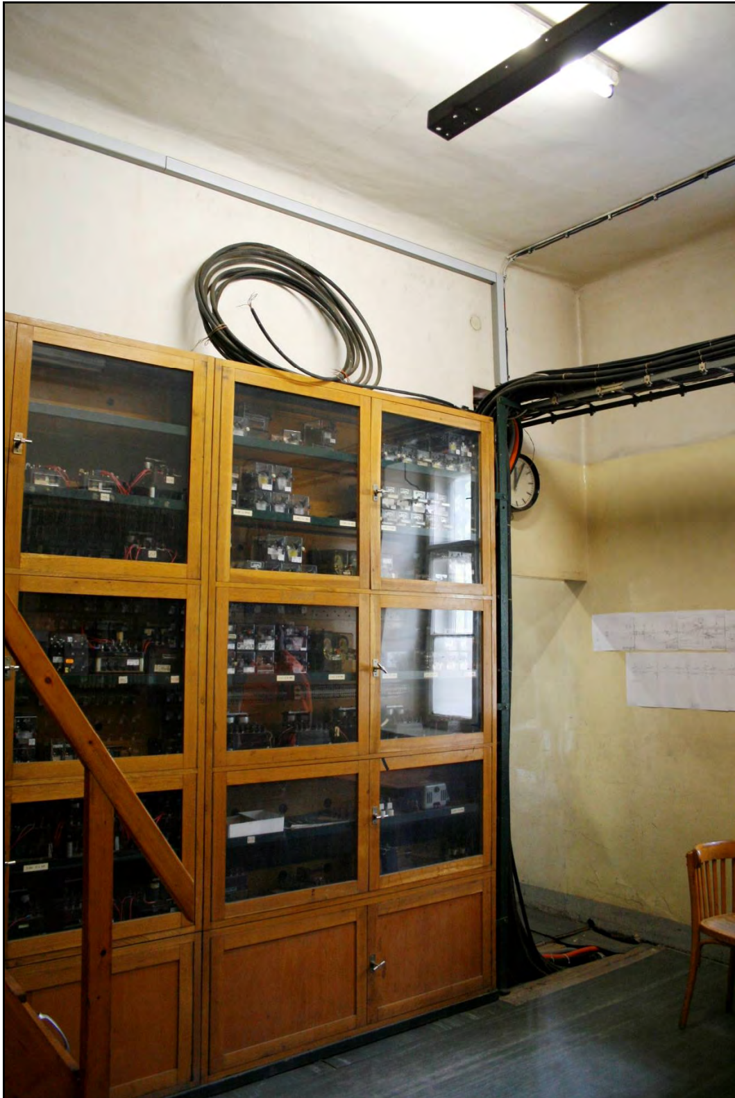
Foto 37 Prostor 111. Pohled na proražený průchod do sousední místnosti 112. Původní vstup se nachází za velkou skříní. Foto 6/2011.
