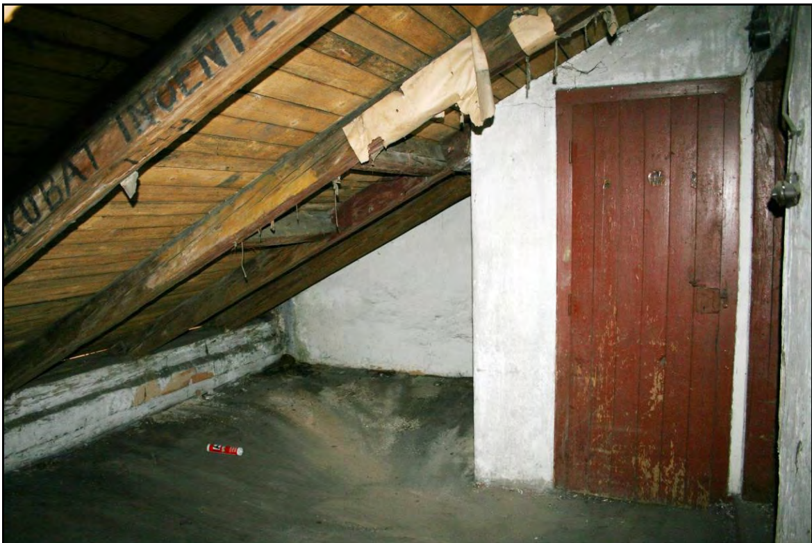
Foto 66 Prostor 408. Pohled do podkroví východního křídla. Na krokvích nabité prkenné deštění. Krokve jsou osazené na pozednice. Foto 6/2011.
