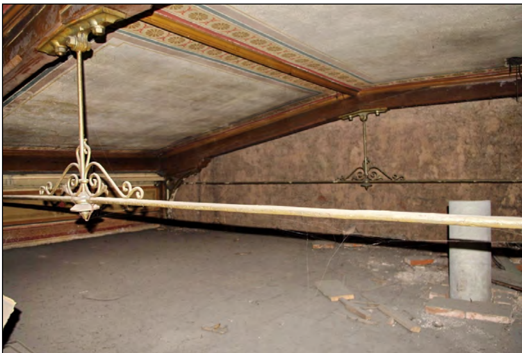
Foto 80 Pohled jihozápadním směrem na původní strop podélného křídla s původní ornamentální výzdobou a kovovými zpevňující táhly z doby výstavby. Strop na snímku se nachází nad dnešním pohledem místností 114 , 115 , 116 a 118 . V pozadí příčka oddělující od prostoru 117 . Foto 29. 7. 2011, kdy byl objekt těsně před odevzdáním průzkumu doměřován.
