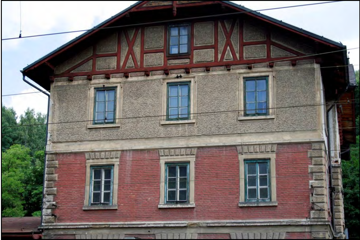
Foto 11 Pohled na obě patra a podkroví jižního průčelí východního křídla. Řešení 1. patra je shodné jako v přízemí. Druhé patro má plochu z hrubé stříkané omítky, profilované šambrány oken jsou hladké. Podkroví je z hrázděného zdiva. Foto 6/2011.
