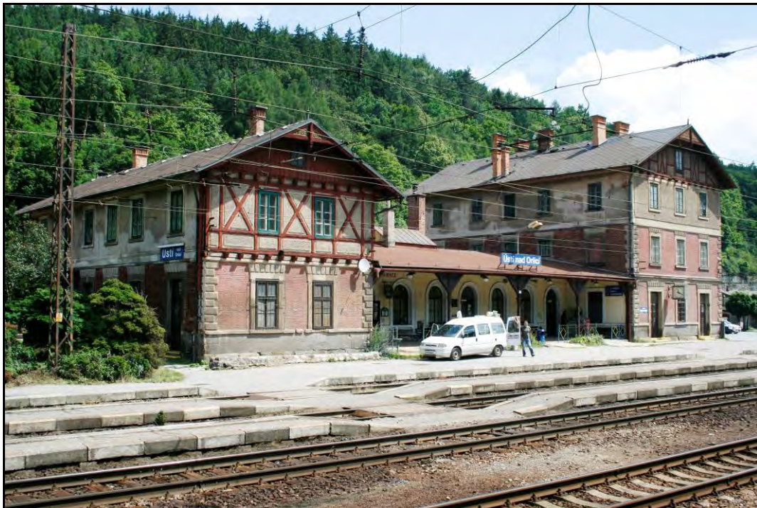
Foto 1 Celkový pohled na výpravní budovu nádraží od jihozápadu (pražské nástupiště). Foto 6/2011.
