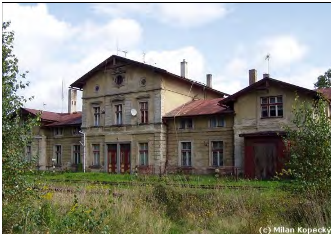
Foto 89 Varnsdorf. Příklad kvalitní architektury z období historismů, v současnosti chátrající. zdroj: http://www.vlak.wz.cz/fotoalbum/varnsdorf_stare_nadrazi.jpg ; vyhledáno 27. 7. 2011
