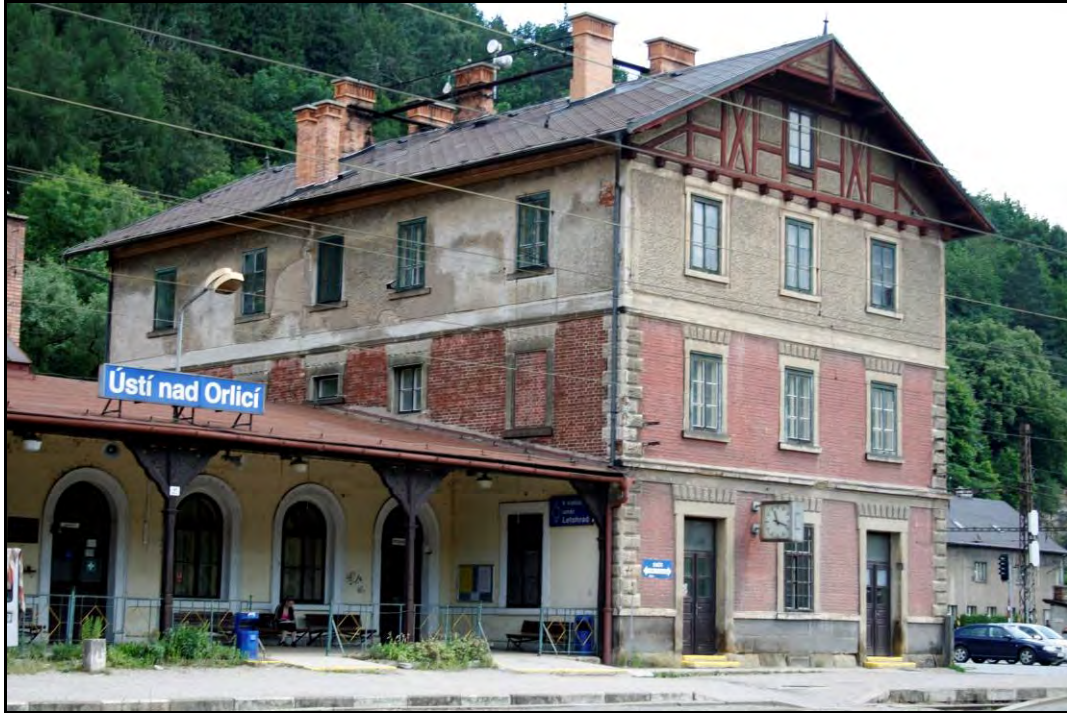
Foto 9 Pohled od jihozápadu na východní křídlo výpravní budovy. Na fotografii jsou vidět obě patra západního průčelí. Přízemí tohoto průčelí je řešeno s rozdílnou úpravou povrchů. Foto 6/2011.
